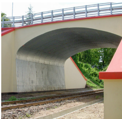
Betonnen kraag – recht uiteinde.
