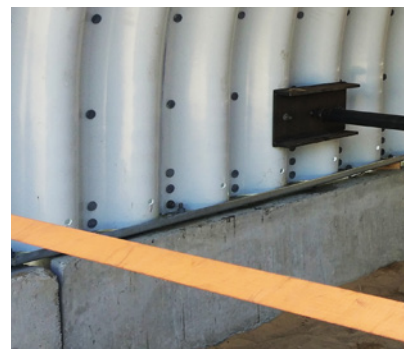
Fig. 8. Aansluiting van de staalconstructie op betonnen funderingen
