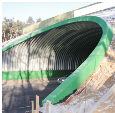
Betonnen frontmuur – talud uiteinde.
